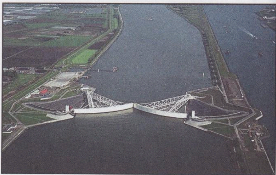
Cửa đập di động Maeslantkering ở cửa sông Maas
